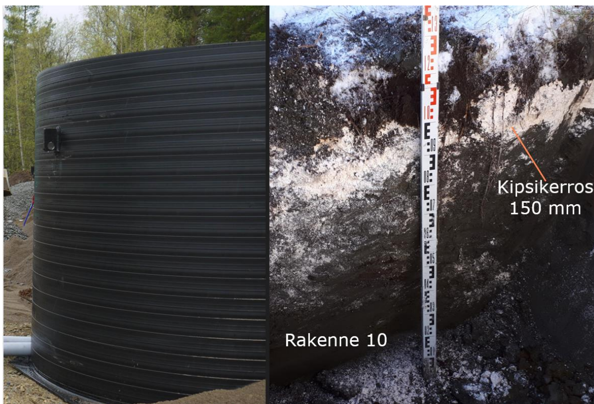
Kuva 3. Koesäiliö asennettuna vasemmalla ja rakennekerrokset purkuvaiheessa oikealla.
