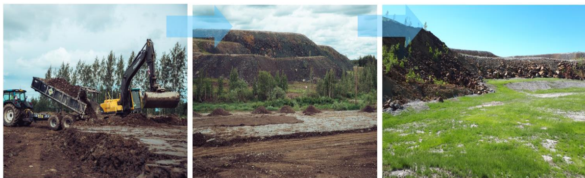
Kuva 8. Savipeitekerroksen rakentamista vasemmalla ja keskellä, oikealla valmista rakennetta.
